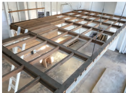
改修後写真 中2階 フローティングフレームを見る
