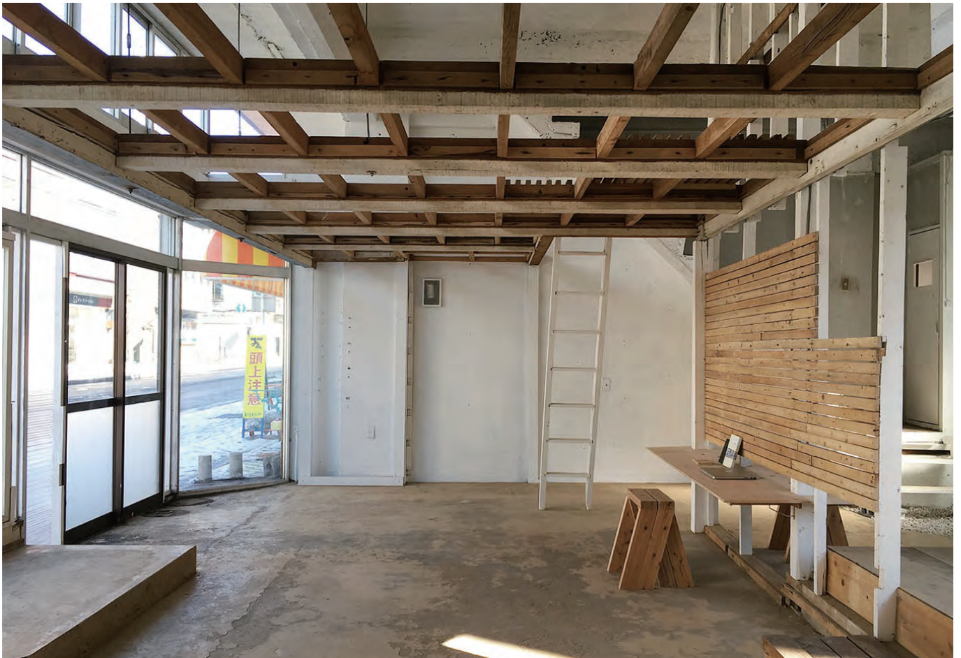
改修後写真 地上階から中2階までを見る
