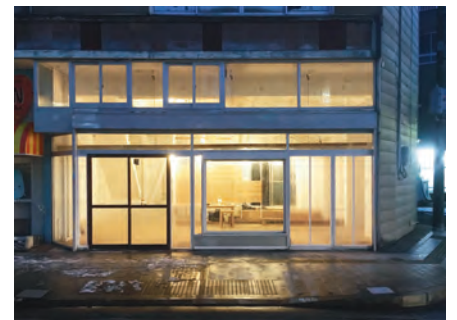
改修後写真 外観 北側立面
