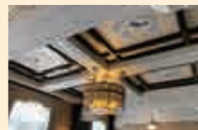
貴賓室の天井は格子状であり、日本の直線美を彷彿とさせる吹寄せや格天井となっている。
