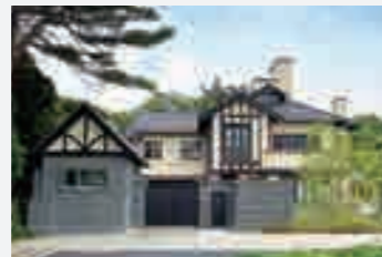
(写真提供/前田建設工業株式会社)
