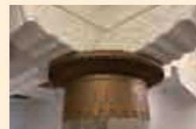
梁を押さえる柱は伝統的な舟肘木に見え、影られているのは若葉の装飾である。
