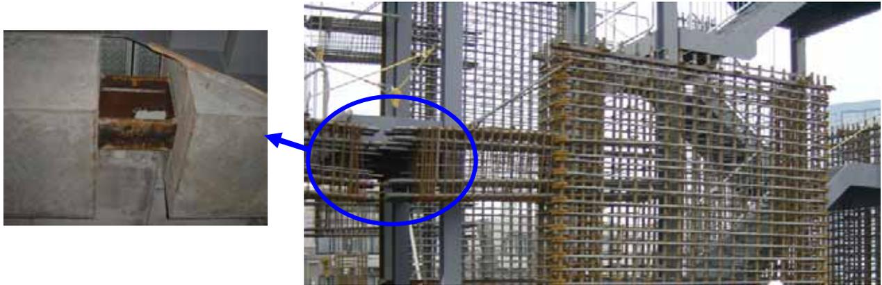
図2： 低降伏点鋼を用いた境界梁ダンパー<sup>8)</sup>
