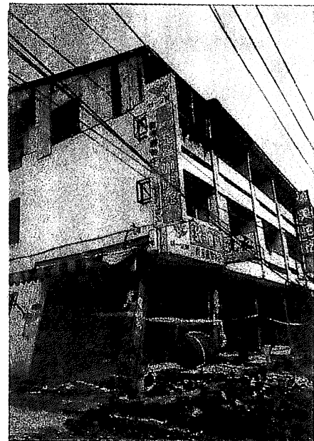
写真10.1999年台湾集々地震により 多数が被災した騎桜型式の R C造建物1階の重心と剛 心の偏心に加え、柱や梁が 細く、柱の帯筋も粗い。
