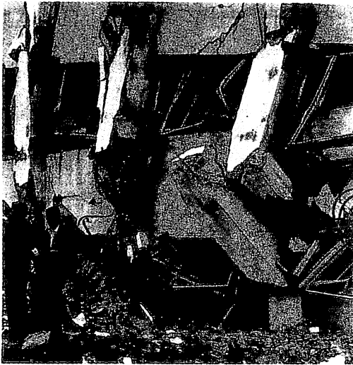
写真5.1968年十勝沖地震により1階が崩壊した函館大学校舎、柱と梁の断面がともに偏平で軸心のずれが大きく、柱や接合部の被害を大きくした。
