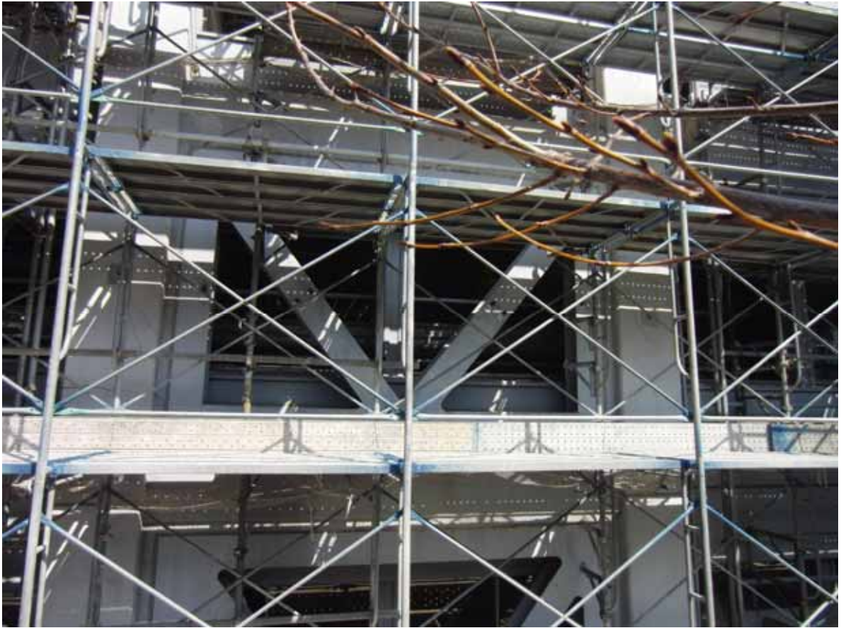
ブレース構面の最終状況
