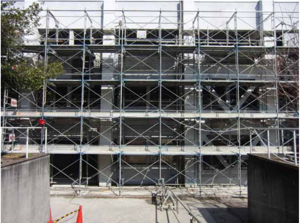
実験風景 (2Fのブレース補強構面の耐力確認。ブレースで補強されているスパンの2スパン左のスパンの3F梁を切断し、そこに3000kN×2台の油圧ジャッキを設置して加力を行った。3Fの柱と、直交する梁、耐震壁、スラブはワイヤーソーで縁を切った)
