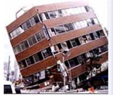
建築基準法が改定された1971年以前に建てられた建物の阪神淡路大地震時の柱せん断破壊、中間階層破壊状況。
