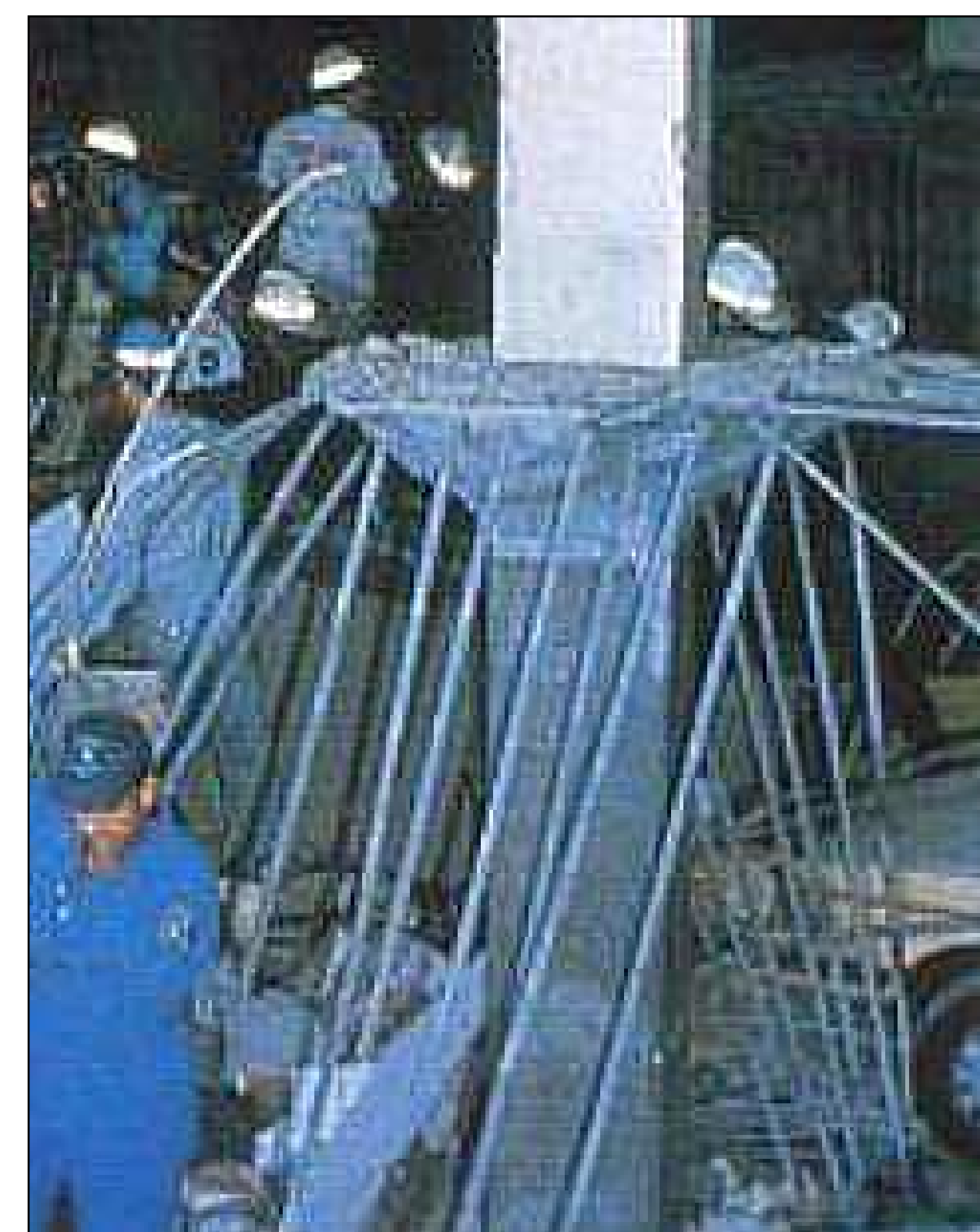
柱-フラットプレート接合部でのパンチングシア破壊
