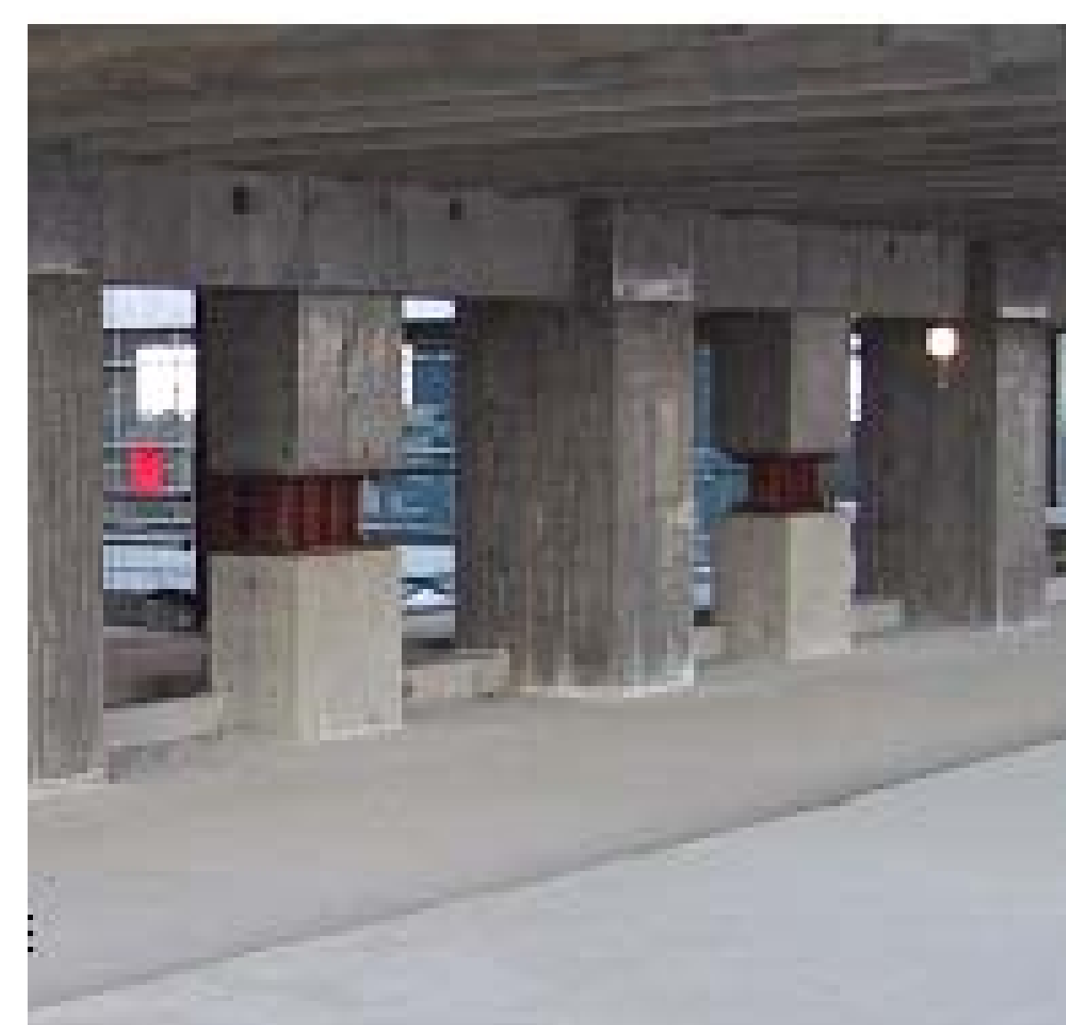
制振部材の設置 (左:間柱型、右:ブレース型)
