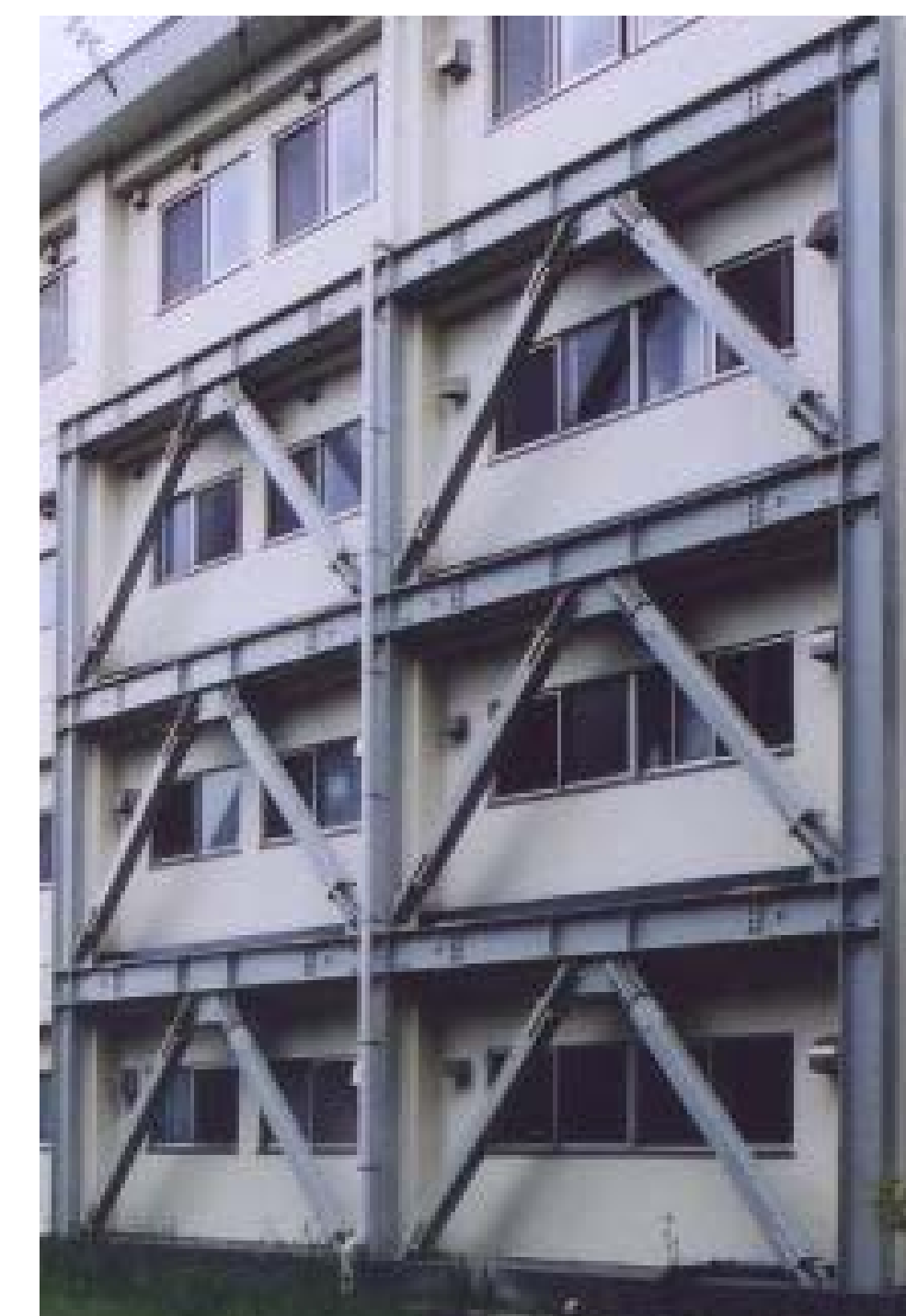
制振部材の設置 (左:間柱型、右:ブレース型)
