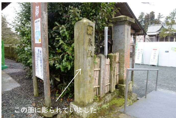
参道・第1駐車場間 玉垣④（南側）
