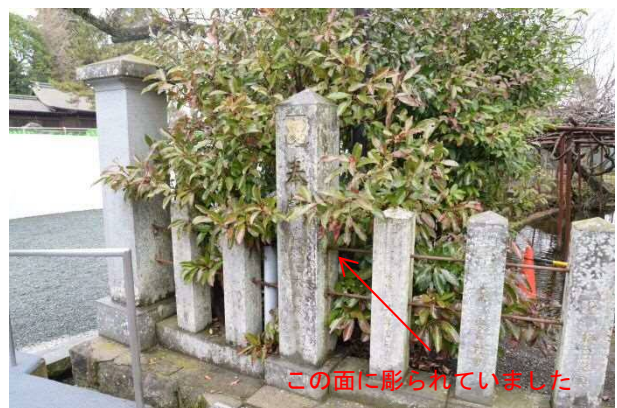
参道・第1駐車場間 玉垣⑤（北側）
