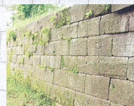
⑬ 数寄屋屋敷(東) [4期創建、5期・6期改修]
