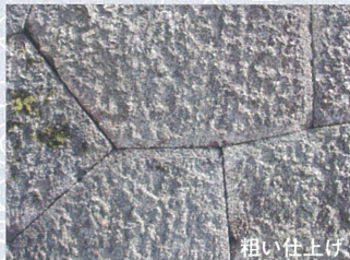
隙間は詰石の欠落 石口に合わせた加工詰石 [4期・本丸戊戌櫓下(西)]
