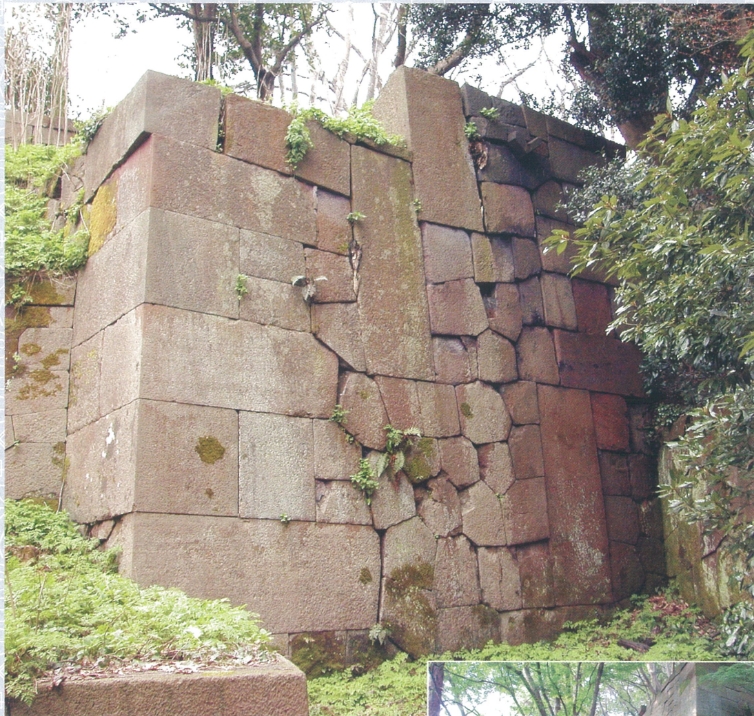
① 二ノ丸居間先の「色紙短冊積」石垣 [5期改修(寛文～元禄頃)] V字形石樋(右上部)からの落水の背景に、縦長石を3段に配置。 石樋には黒色の「坪野石」を使う。庭園借景石垣の代表例。
