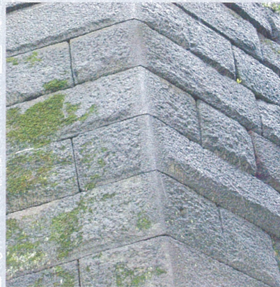
隅角部の稜線を縁取る「江戸切り」 [5期・薪ノ丸]
