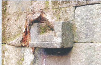
二ノ丸御殿の雨水を落した石樋 [6期・数寄屋屋敷東]
