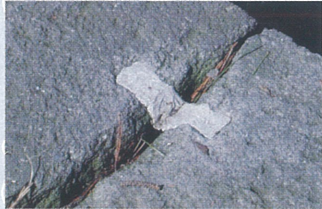
切石積石垣の天端を留める 鉛のチギリ [6期・河北門]
