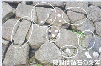
隙間は詰石の欠落 石口に合わせた加工詰石 [4期・本丸戊戌櫓下(西)]
