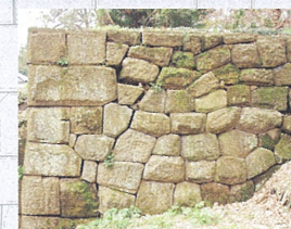
⑭ 数寄屋屋敷北西 [4期創建、5期改修]
