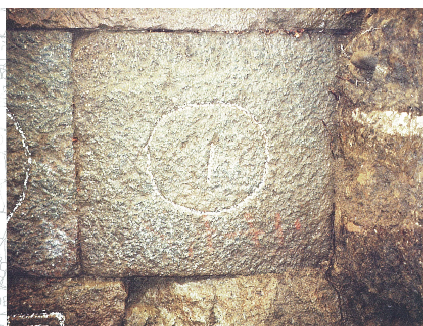
⑨ ニノ丸五十間長屋(西面) [4期創建(寛永8年 1631)] 切石積石垣は、当初、五十間長屋や数寄屋敷等、ニノ丸御殿周辺の石垣と、ニノ丸から本丸へ至る通路周辺の石垣に限って採用された。正面を正方形に整えた石材を多用し、緻密で整然とした壁面を構成する。
