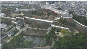
の丸櫓群・長局(百間廊下) 山に建てられた西の丸の外周をめぐる櫓群。原生林を活かし、自然の地形にわせて延々と続く珍しい建物。背後の室や狭間を見ると厳重な防備を持滅郭であることがわかります。
