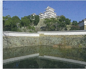
三国堀 姫山と鷺山の間に設けられた四角い堀。二の丸につながる「いの門」と「るの門」の要所をおさえる重要な位置にあります。
