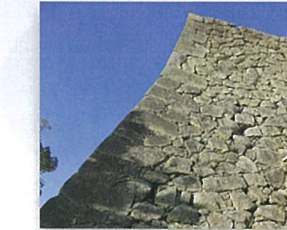
扇の勾配 開いた扇の曲線に似ていることから「扇の勾配」と呼ばれる石垣。上に行くほど反り返り、敵に石垣をよじ登らせないための工夫でもありました。
