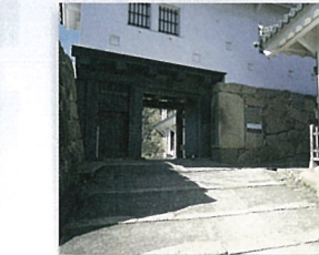
備前門 折廻櫓に続く切妻の櫓門で、備前丸への主要な出入口となる城門です。築城の際、石不足であったため、門のすぐ脇には石棺が転用されています。
