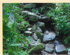
屯水地区の水門
