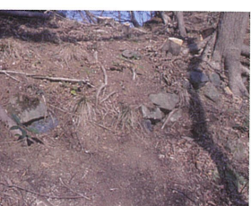
⑦連郭曲輪群Ⅲ郭南面石垣
