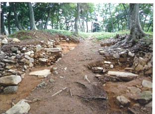
⑤本丸北西虎口石垣（左）と北側石垣面の倒れた鏡石（右）
