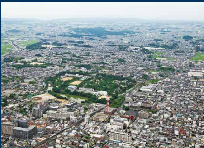
全景（南東上空から）
