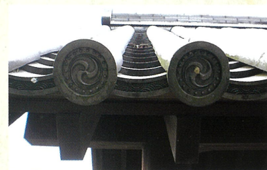
城内の東屋の屋根には、出土した瓦のレプリカが葺かれています。
