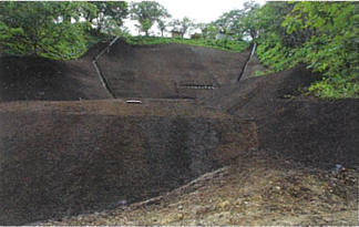
楯山公園北側斜面の復旧状況
