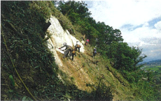
楯山公園南側斜面の復旧工事
