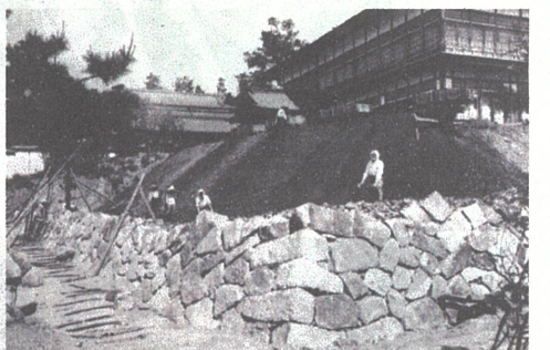
現在の万祥殿前庭・南東部分の石積みをする大本信徒。石垣は壊され大半が土中に埋まっていた。石には天下普請の証しとしての諸大名の刻印が散見される
