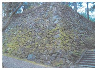
5 復元された天守石垣。下から約3分の1は、光秀公築城当時の穴太積みが奇跡的に残っている
