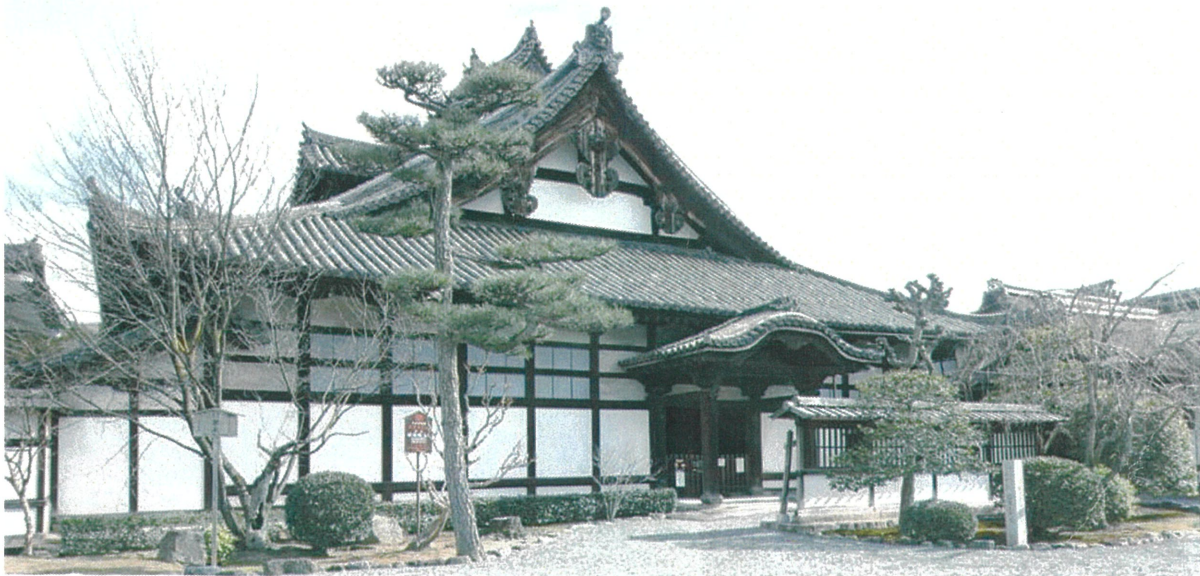
庫裏 修理前 外観
