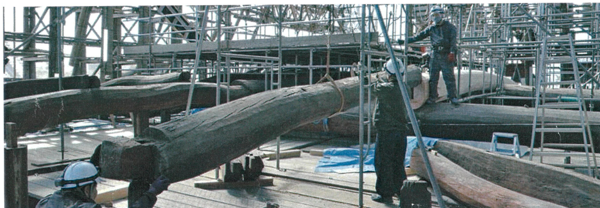
庫裏 梁組立中の状況
