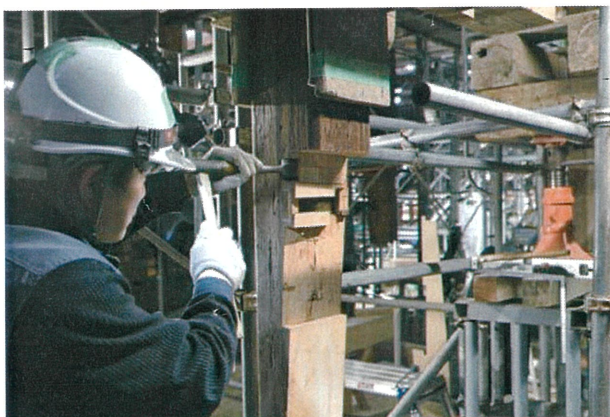
庫裏 柱根継加工状況
