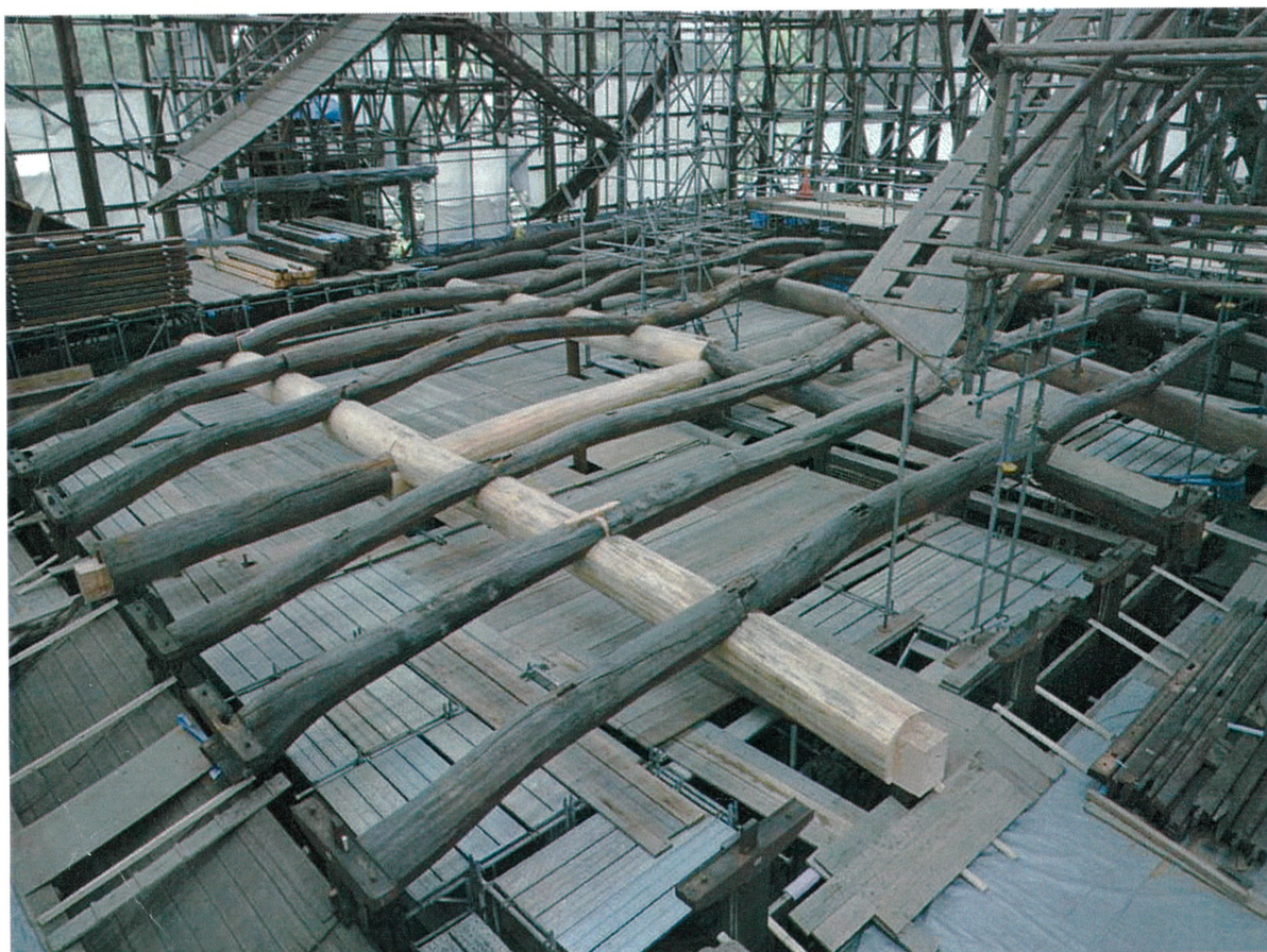
庫裏 梁組立完了の状況
