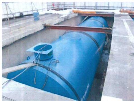
防災事業の例 (防火水槽)
