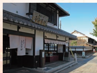
夢京橋キャッスルロード
