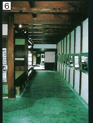
施設内に入っすぐ見渡せる土間。数多くの柱や梁が重厚な空間をつくりだしています。梁の材質はマツ。ここは店ではなく勝手口で荷車が玄関と奥にある土蔵を往来していた空間であったといわれています。
