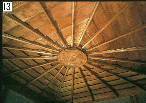
トイレの隣の浴室の天井も見て下さい。天井板が少しずつずらしてあり、蒸気が逃げるといったデザインになっています。
