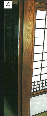
女柱といわれる大黒柱。柱の面が丸く削られています。
