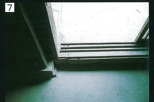
取り外し可能な入り口の溝。(現在は不可)荷車が通るときには外していました。
