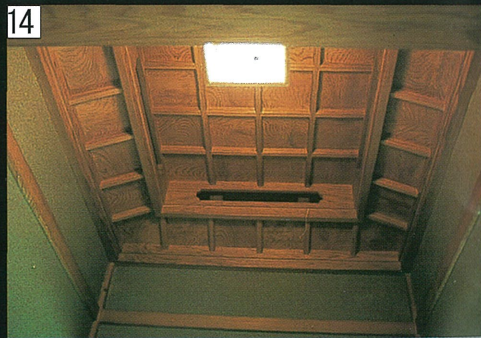
トイレに入ったら天井を見て下さい。屋根から換気ができるデザインになっています。
