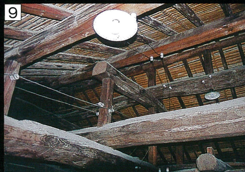
主屋の小屋組は居室上部の梁間3間半の二重梁、土間上部の1間半の下屋を組み合わせて構成されたもので、吉井では古めかしい構造です。
