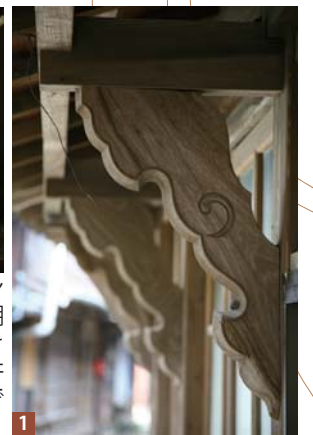
①持ち送り：建築時代ごとにデザインが異なる②町屋の内部意匠：帯戸戸棚と階段下の箱階段③摺り上げ戸：引き戸以前はこれが主流だった④共同井戸：主要な水源として昭和40年代まで使用されていた
