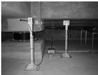
写真2 免震層の変位観測装置と地震計
