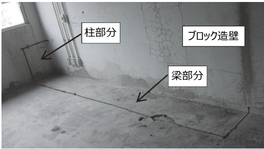
(d) 柱・梁接合部を含む梁試験体 写真1 部材切り出し状況
