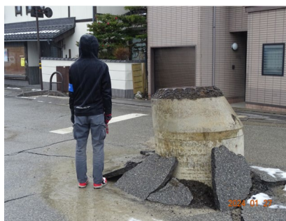
被害調査 (液状化)
