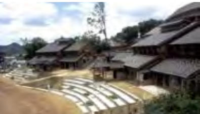
[図14] いるか設計集団「出石町立弘道小学校 (1990)
