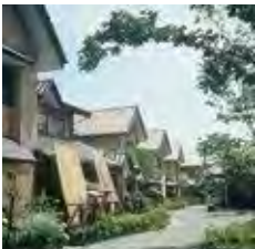
[図 15] いるか設計集団「城崎町営内島団地」(1993)
